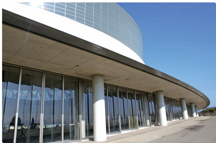
回転扉(パークドーム)
