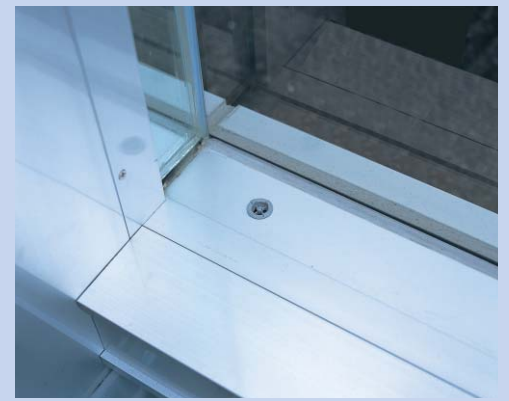
結露抜き(ドレンキャップ)の様子
